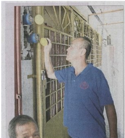
↑ 龙仕武带领记者检查组屋的水表。
